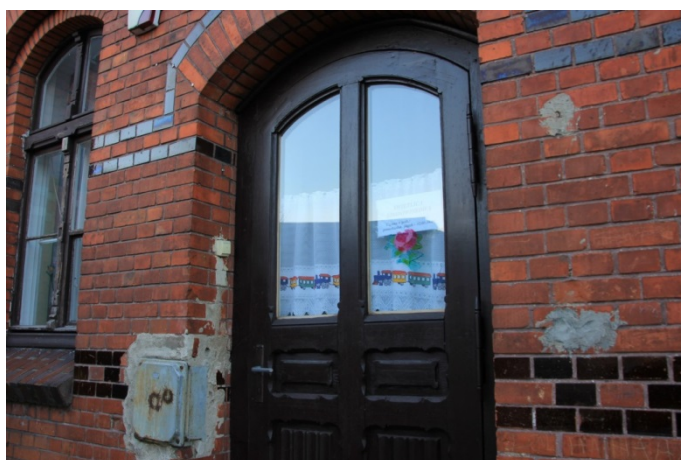
sugerowana wymiana uszkodzonych cegieł
